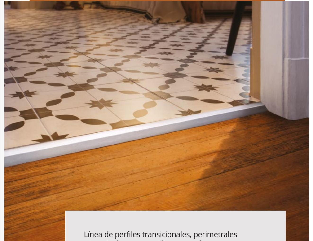
Línea de perfiles transicionales, perimetrales y terminales que se utilizan para decorar y separar pisos en el mismo nivel o en diferentes alturas. Variedad de anchos con vistas planas y redondeadas, que se adaptan a los diferentes estilos en áreas residenciales y comerciales.
