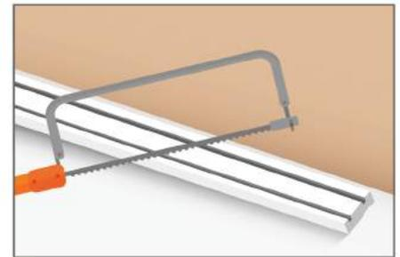
**3.** Utilizando como referencia las líneas trazadas en el paso 1 (o con el marco de la abertura) corte los contramarcos correspondientes a los laterales y travesaño de la puerta. En ambos perfiles verticales, el extremo superior deberá estar cortado a 45°. Considere cortar los ángulos en sentido izquierdo y derecho. Mida la longitud del trazado horizontal y corte el contramarco superior de la puerta.
