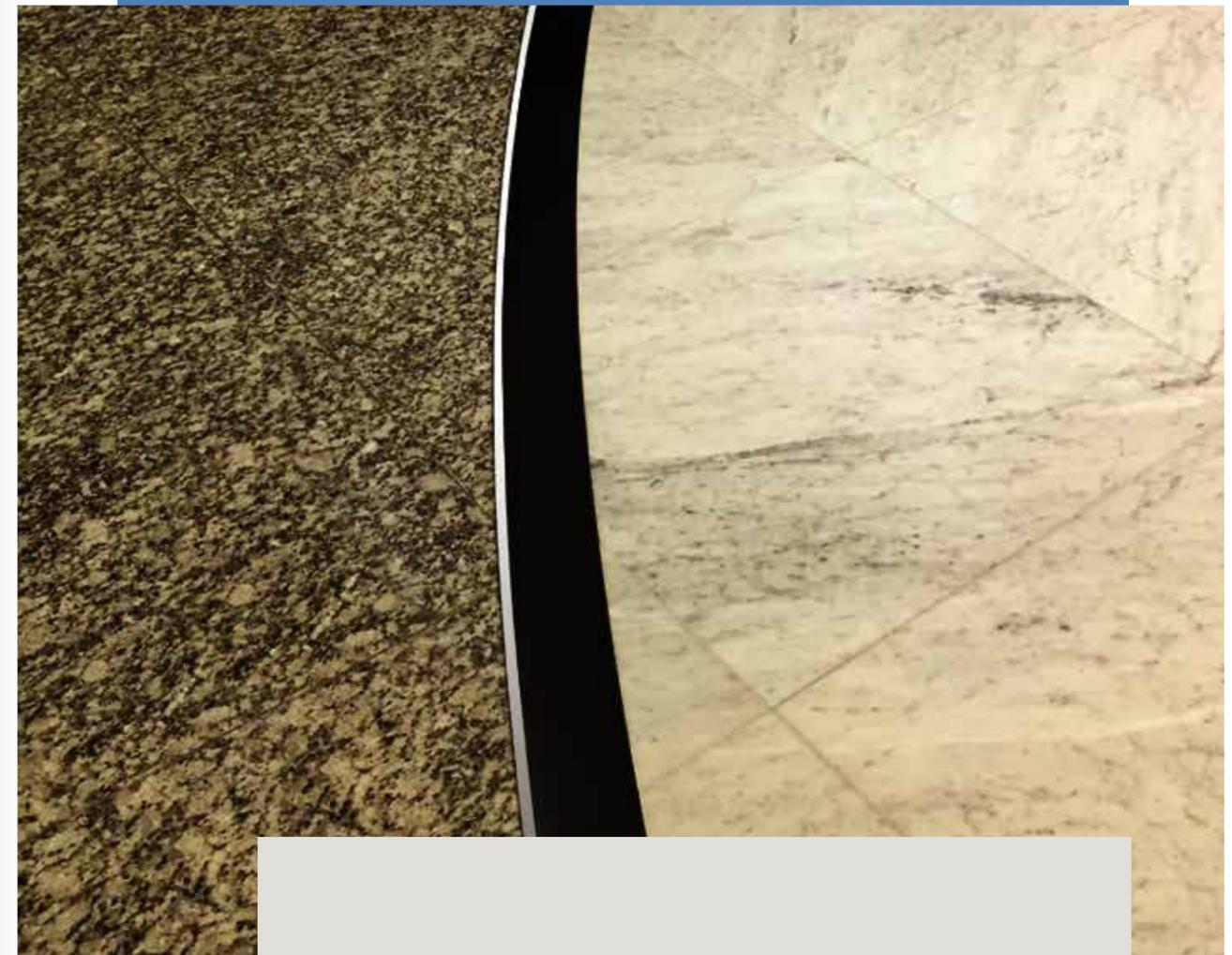
Perfiles multifacéticos que generan dibujos y formas en pisos y paredes, mesadas y escaleras, a la vez que protegen los bordes de los revestimientos.
