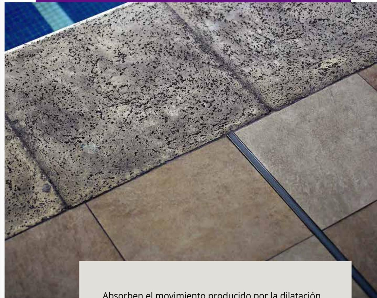
Absorben el movimiento producido por la dilatación y/o contracción de los materiales evitando rajaduras y roturas de cerámicos. Las juntas de acero y bronce resisten al alto tránsito y permiten además su colocación a la intemperie.
