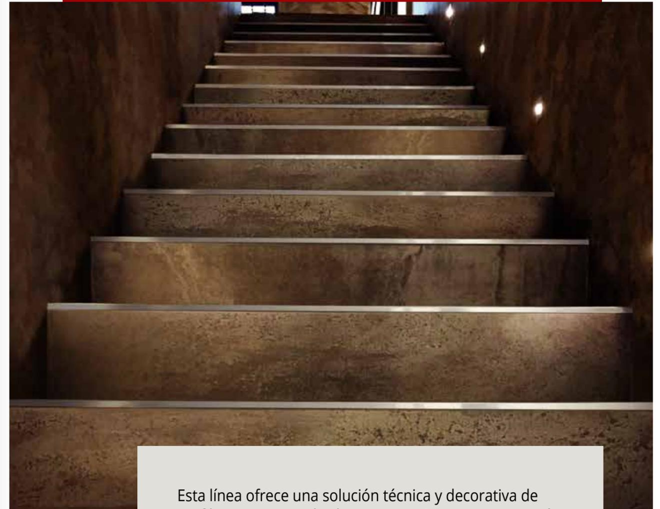
Esta línea ofrece una solución técnica y decorativa de perfiles curvos, cuadrados y rectos. Crean una transición entre revestimientos de diferentes materiales, compensan alturas y protegen los bordes. Fabricada en acero 304 de gran resistencia y brillo, permite crear un diseño moderno en pisos interiores y exteriores.
