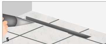
5 Aplique sellador de silicona en el perímetro de la junta. Para conseguir un corte limpio de las piezas utilice una máquina de corte.
