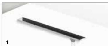
1 Determine el lugar donde será instalado. Marque el contorno del desagüe en la superficie. Adhiera el conector (40 DM) con el caño de desagüe, utilizando pegamento en la conexión.
