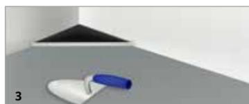
3 Rellene la carpeta hasta el nivel de las pestañas salientes y verifique que exista una mínima inclinación hacia el desagüe.
