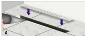
6 Aplique sellador de silicona en el perímetro de la junta. Retire el film protector y coloque la tapa.
